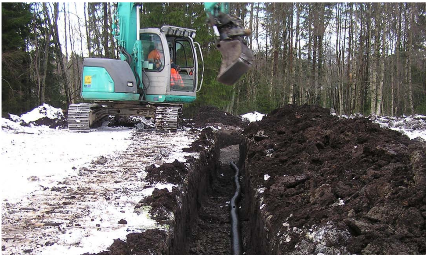
Kuva 1. Salaojaputket laskevat maaperän vedenpintaa. Kuva: Agnar Kvalbein
