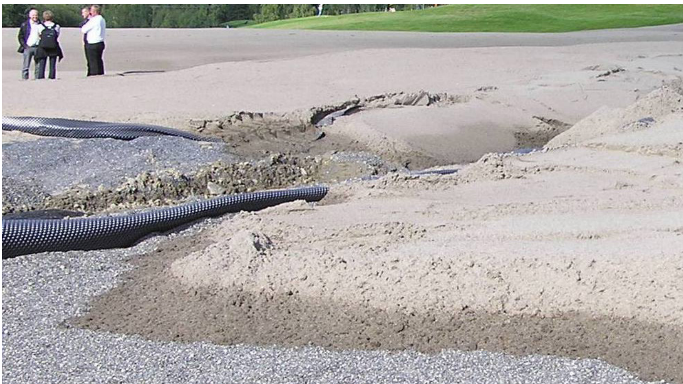
Kuva 2. Orsiveden pinta syntyy, kun hienompijakoista maa-ainesta laitetaan karkeajakoisemman maa-aineksen päälle. Kuva: Agnar Kvalbein.
