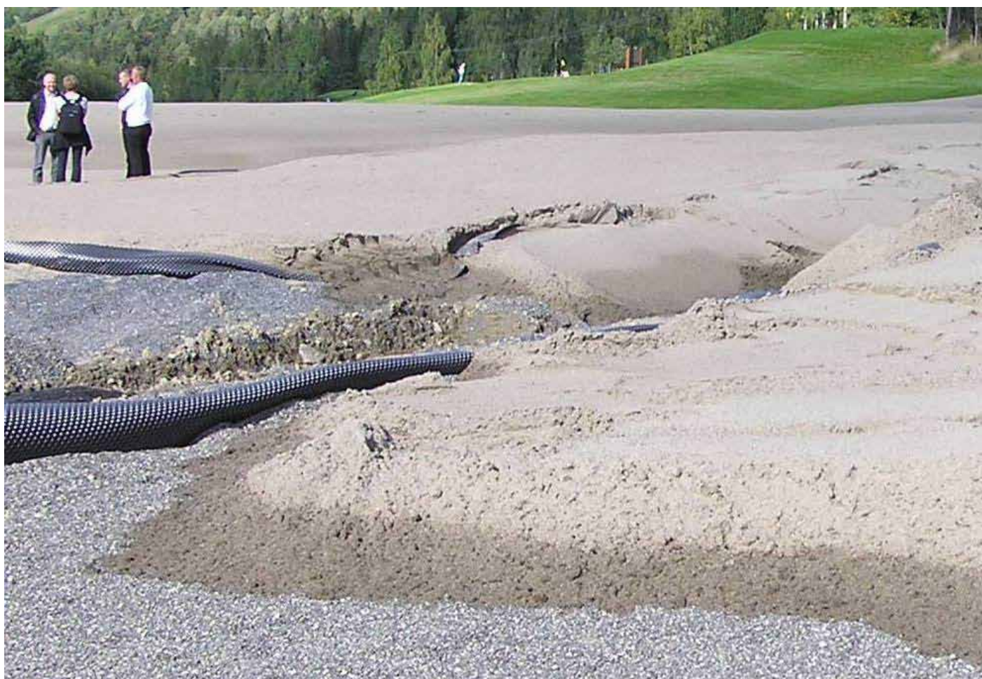
Billede 2. Når vi lægger finkornet jord ovenpå grovere, skabes der et såkaldt hængende vandspejl (engelsk: perched water table). Foto: Agnar Kvalbein.
