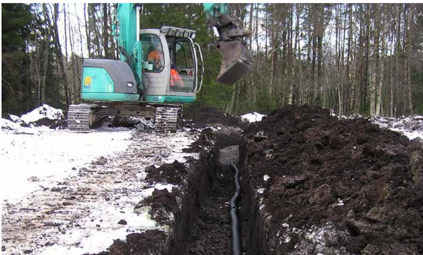
Billede 1. Drænrør gør det muligt at sænke grundvandsspejlet i jorden. Foto: Agnar Kvalbein.
