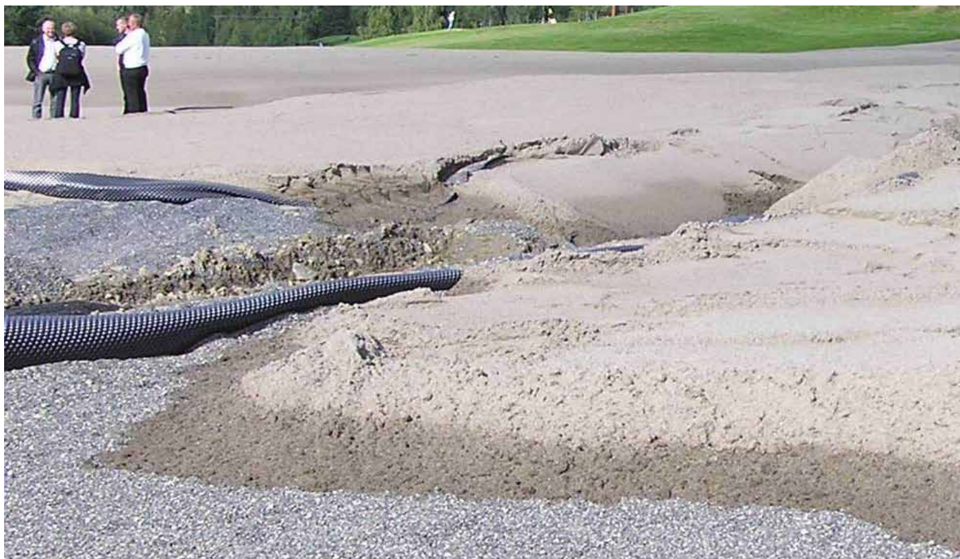
Bilde 2. Når vi legger mer finkornet jord oppå grovere, skapes et såkalt hengende vannspeil (engelsk: perched water table ). Foto: Agnar Kvalbein.
