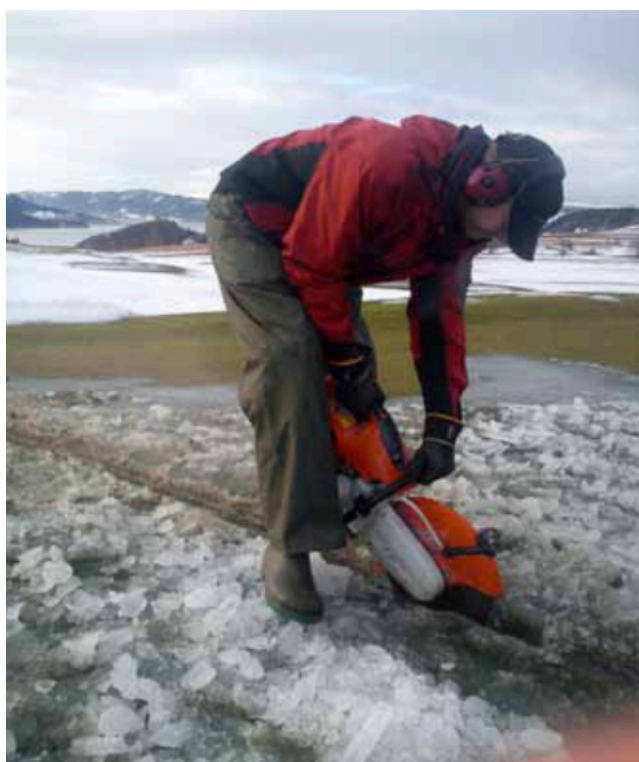
Asfalttileikkuria käytetään vedenpoiston parantamiseen viheriöiltä. Kuva: Ole Albert Kjøsnæs, Byneset golf.
