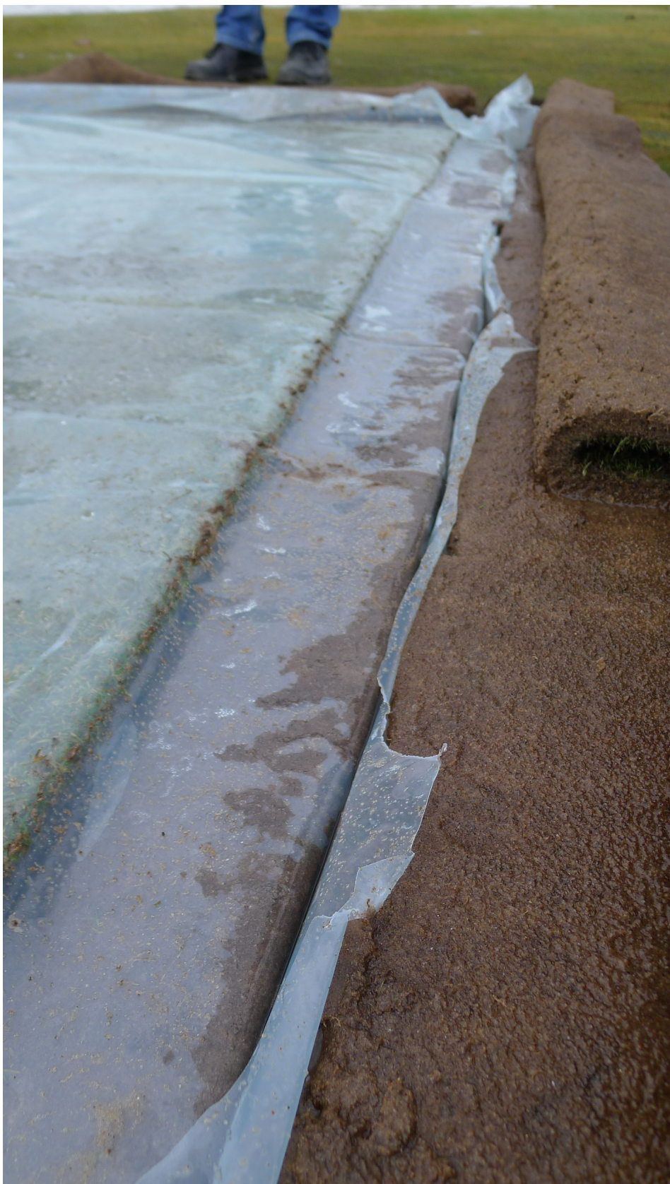
Plast er gravet ned rundt om greenen og kanten forsejlet med græstørv skåret med tørv-cutter. Dette er nødvendigt for at forhindre at vandet trænger ind under dækket. Foto: A. Kvalbein.
