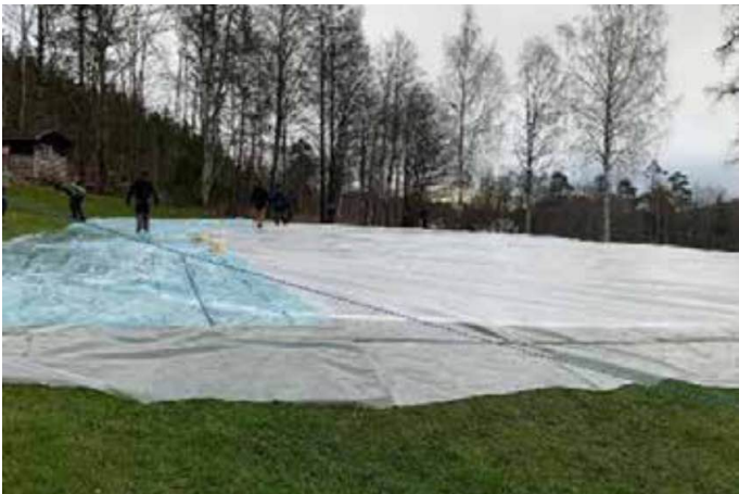
Kuva 27. Kestävä Green Jacket -peite asennettuna Haga GC:lla, Norjassa. Vedenpitävän peitteen alle on asennettu salaojaputket ilmanvaihtoa varten. Kuva: Gavin Jagger.
