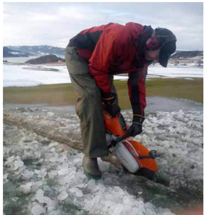
Kuva 23. Viheriöiden väliaikaiset ojat vaativat huoltoa talvella. Käytössä asfalttileikkuri. Kuva: Ole Albert Kjosnes, Byneset GC, Norja.
