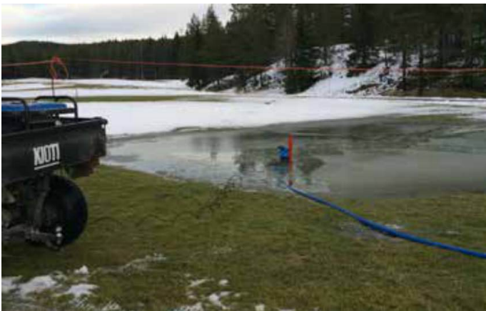
Kuva 25. Sulamisveden poistaminen viheriöltä siirrettävällä pumpulla. Kuva: Allan Ferm, Grønmo GC, Norja.
