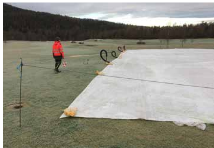
Foto 26. Green Jacket installerad på Haga GC, Norge. Dräneringsrör för ventilation har installerats under den täta duken. Foto: Gavin Jagger.
